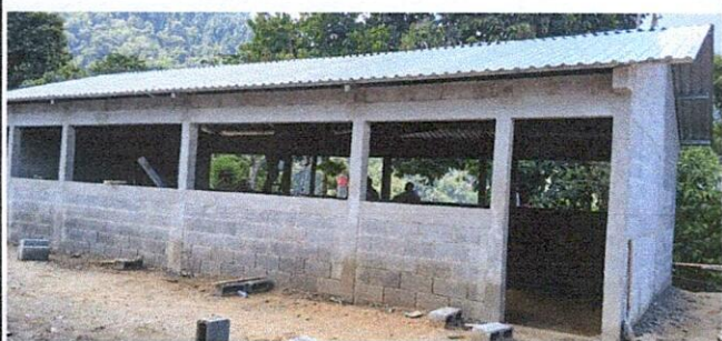
Foto 5: Mantenimiento módulo tipo portico, pared con block
