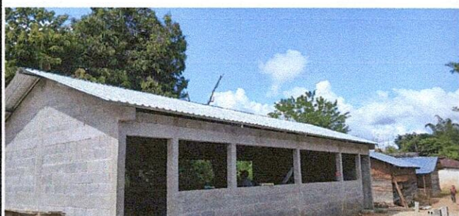
Foto 3: Mantenimiento módulo tipo portico, cubierta de lámina de techo
