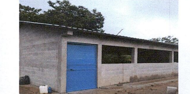
Foto 6: Mantenimiento módulo tipo portico, instalacion de puertas de metal
