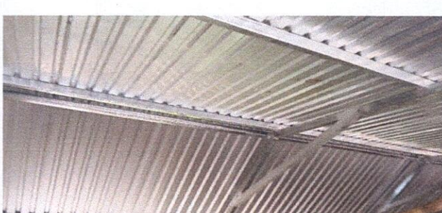
Foto 4: Mantenimiento módulo tipo portico, estructura de techo
